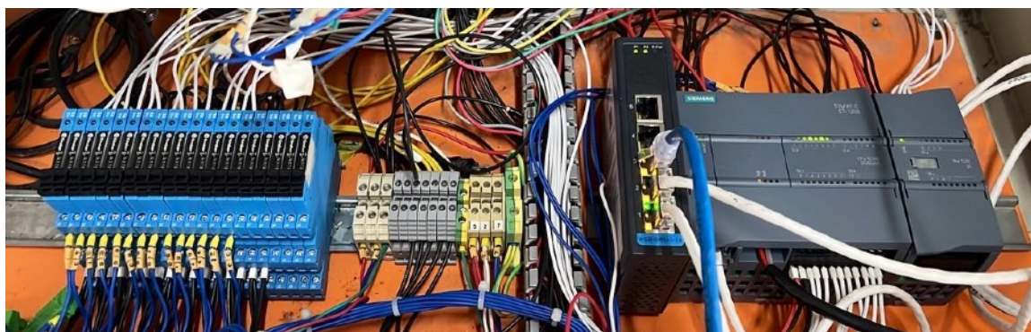
Interior do painel elétrico com o CLP atualizado incluindo switch para comunicação Ethernet.
